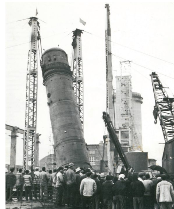
土法上马吊装合成塔，长中国人志气
