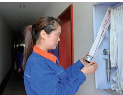
11. 许春平检查消防栓
