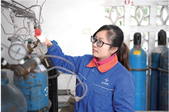
13. 安全员专项检查高压气瓶是否漏气
